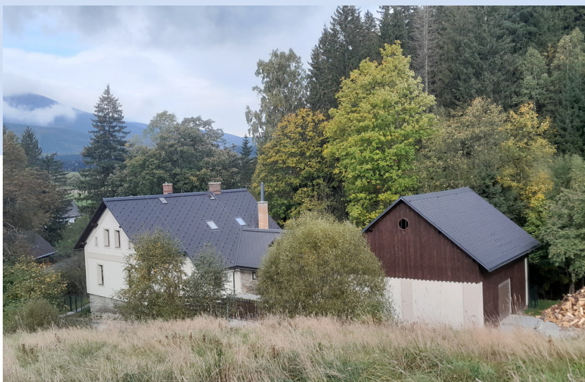
Rekonstrukce hájovny Domašov, lesnický úsek Borek, polesí Domašov
