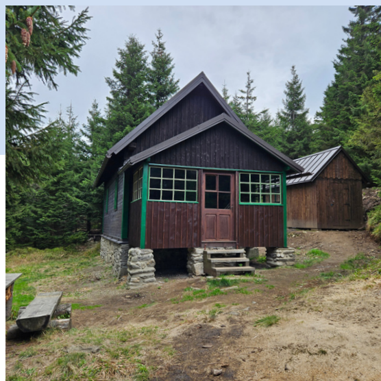
Oprava chaty Tetřeví, polesí Rejvíc
