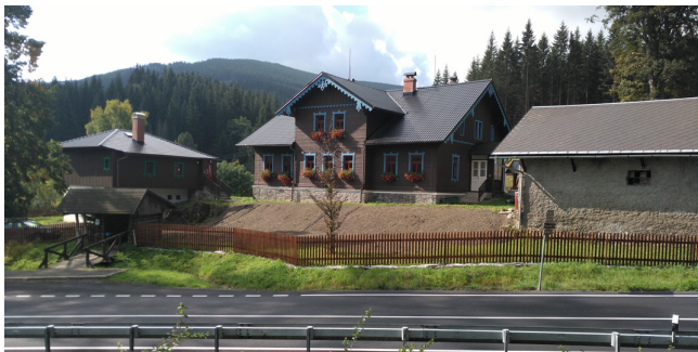
Budova Lesní práva Vrbno pod Pradědem Foto: Karel Strzinek
