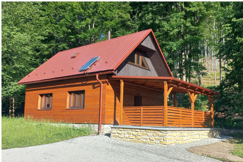
Oprava chaty Chaloupka, polesí Chvalčov
