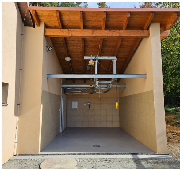
Přístavba odvěšovny na zvěřinu u hospodářské budovy hájenky, polesí Kroměříž
