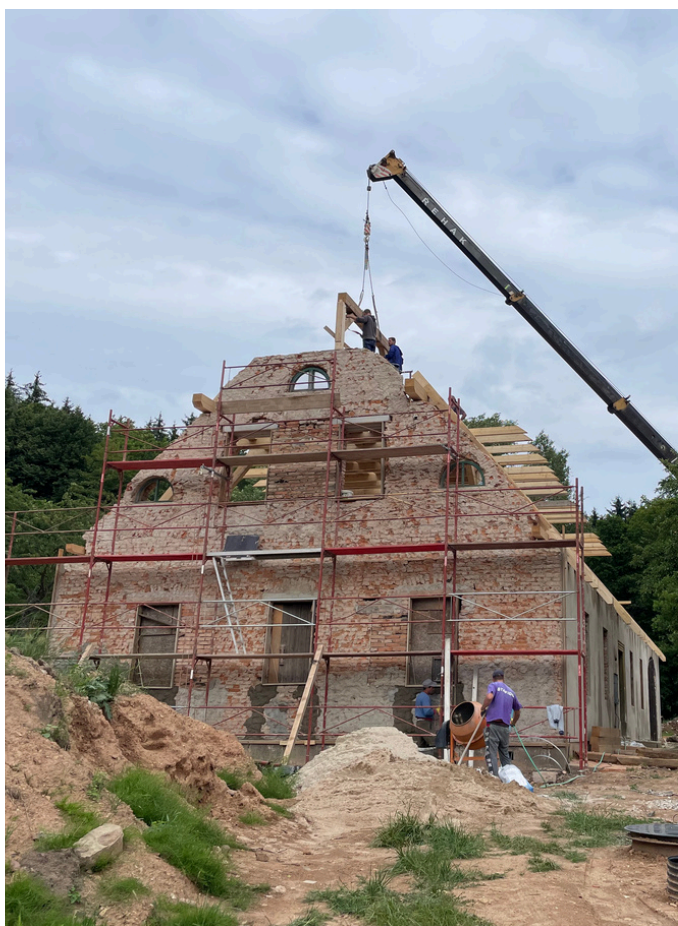
Hájovna Řeřišný – začátek rekonstrukce
