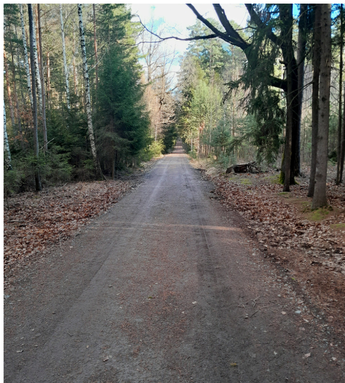
Opravená lesní cesta
