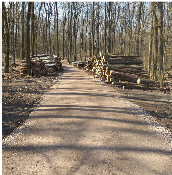
Opravená lesní cesta
