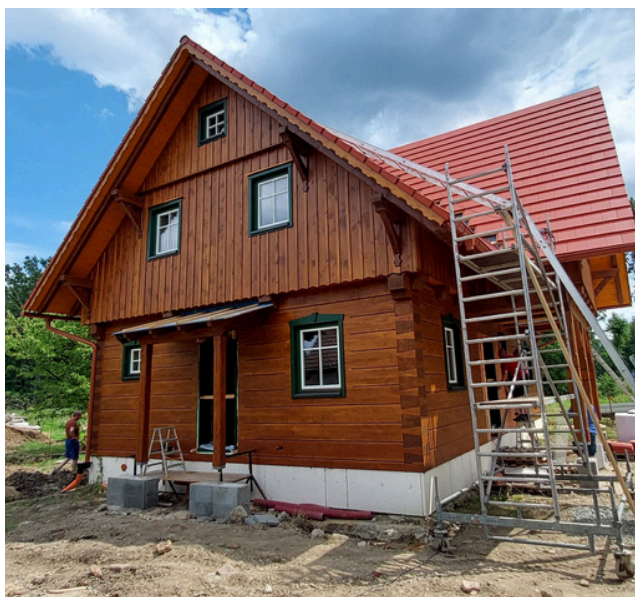
Výstavba Dolnozahradské hájenky, polesí Kroměříž
