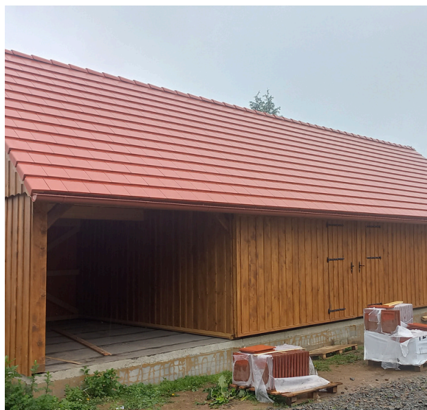
Výstavba hospodářské budovy u hájenky Dolnozahradská, polesí Kroměříž
