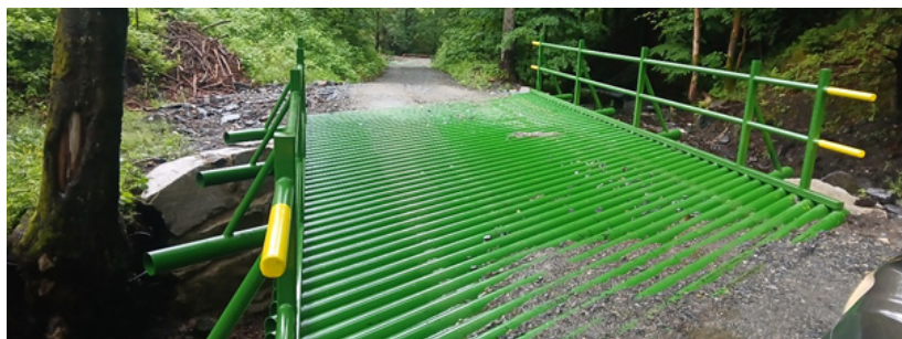
▲ Most na LC Stará Rejvázská
