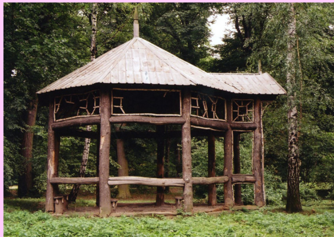
▲ Fotodokumentace stávajícího stavu - 2026
